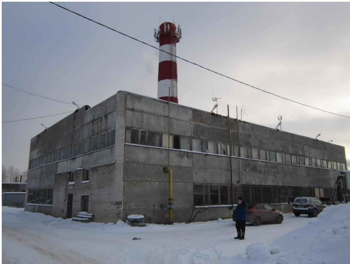
Рисунок 1.2.1.1. Внешний вид котельной №36 пос. Романовка
