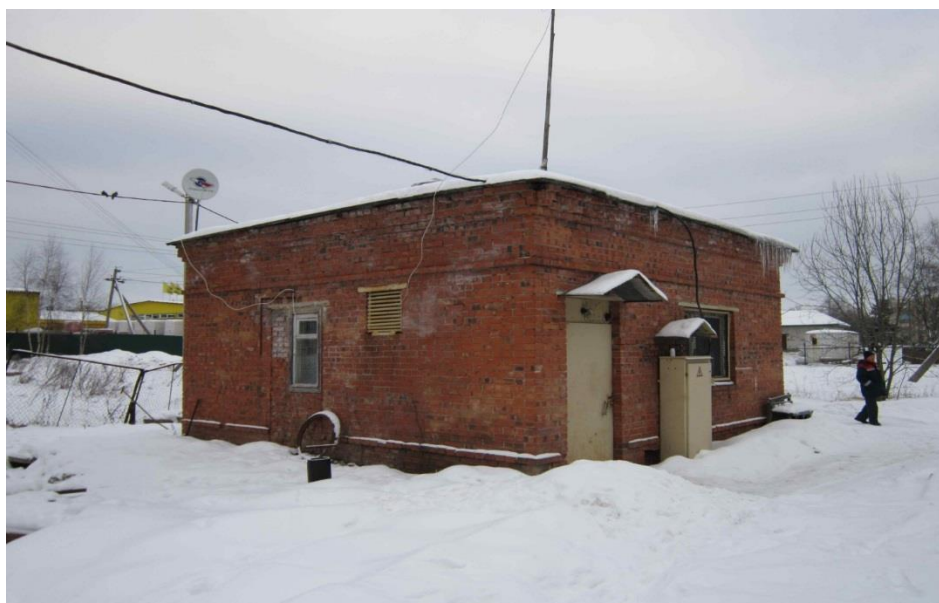
Рисунок 4 – Канализационная насосная станция №2
