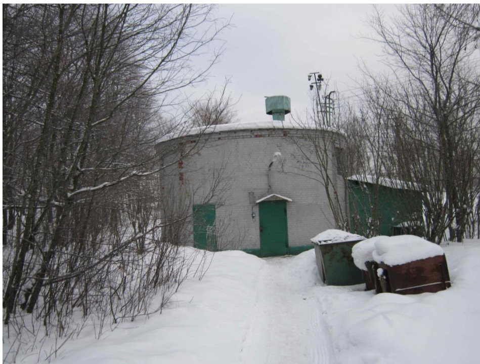
Рисунок 3 – Канализационная насосная станция №1
