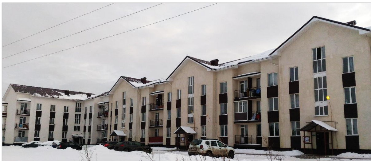
Рисунок 1.5.а – Многоквартирный дом в пос. Углово
