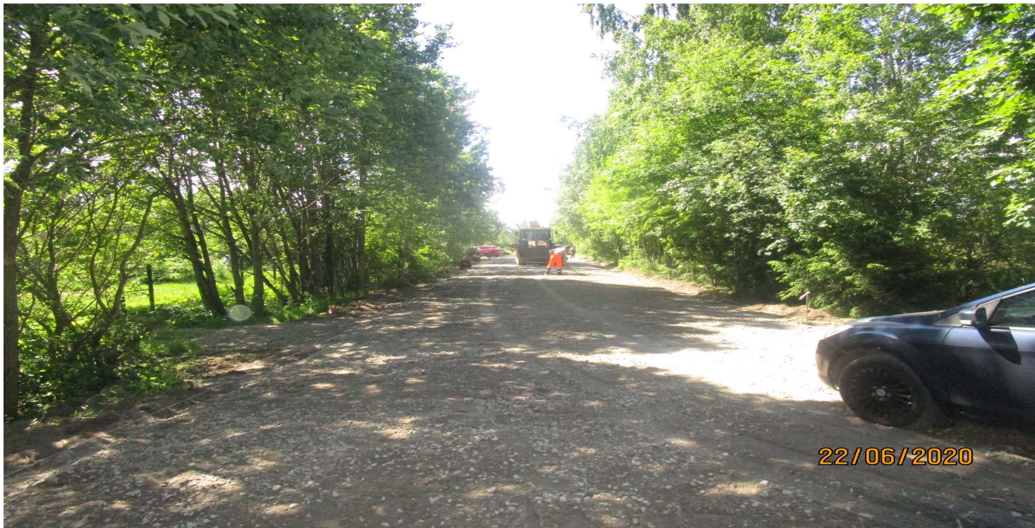
Приложение 6 Ремонтные дороги по улице Центральная, поселка Романовка
