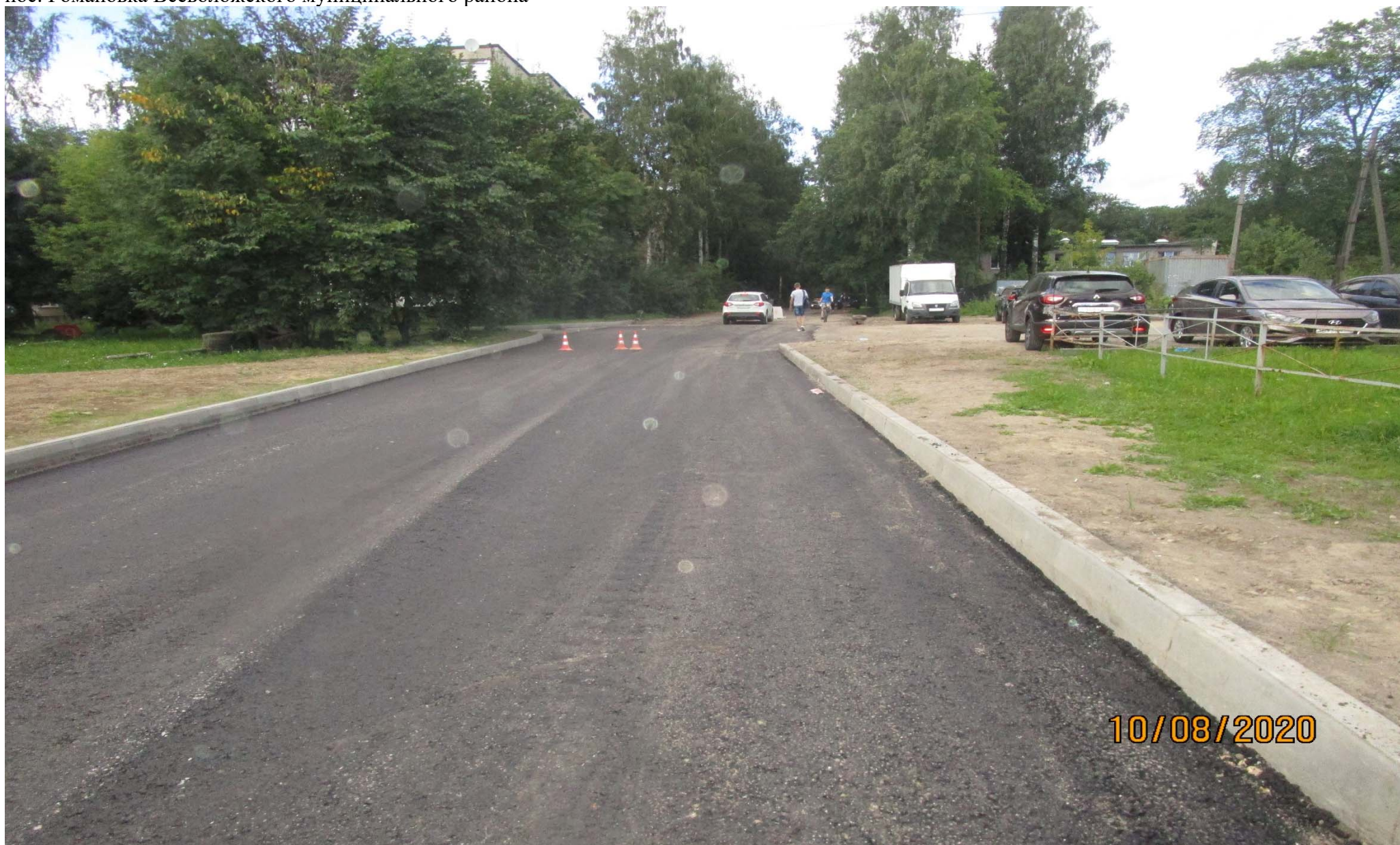
Приложение 9 Выполнение работ по ремонту участков внутридворовых дорог от МКД №5 до МКД №11 с обустройством парковочной площадки в пос. Романовка Всеволожского муниципального района
