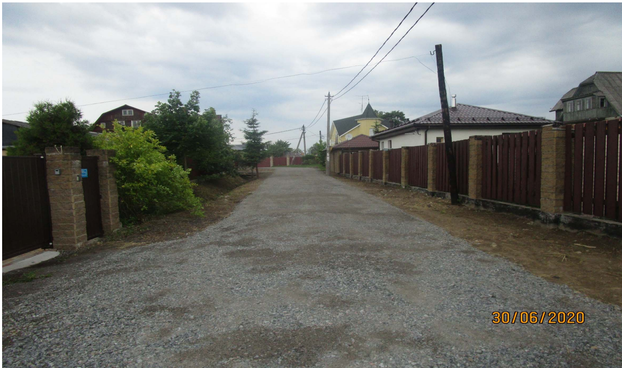
Приложение 7 Ремонтные работы по улице Верхняя, поселка Романовка
