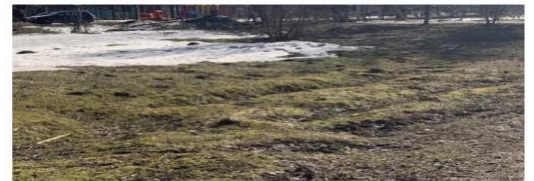
Неровный рельеф. В эксплуатации такой рельеф трудно убирать, косить газон, происходит застой воды
