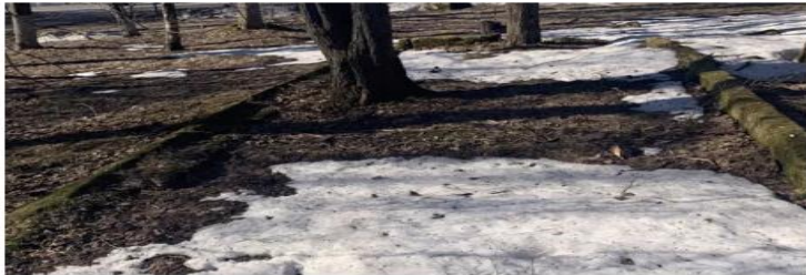
Остатки фундаментов старых домов требующие демонтажа и утилизации
