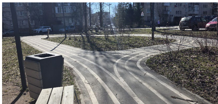
Благоустройство общественной территории. Ленинградская область, Всеволожский район, пос. Романовка, сквер от Дороги Жизни до МКД № 16,18 – 2023 год
